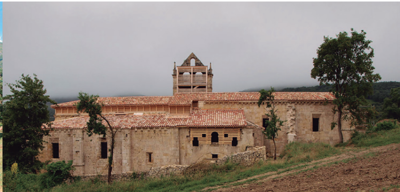
Antes y después de los trabajos en el monasterio de Rioseco.
